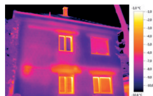
Image thermique avec testo ScaleAssist
